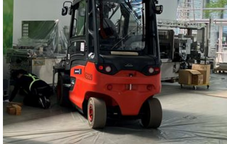
⑦機械の据付作業
